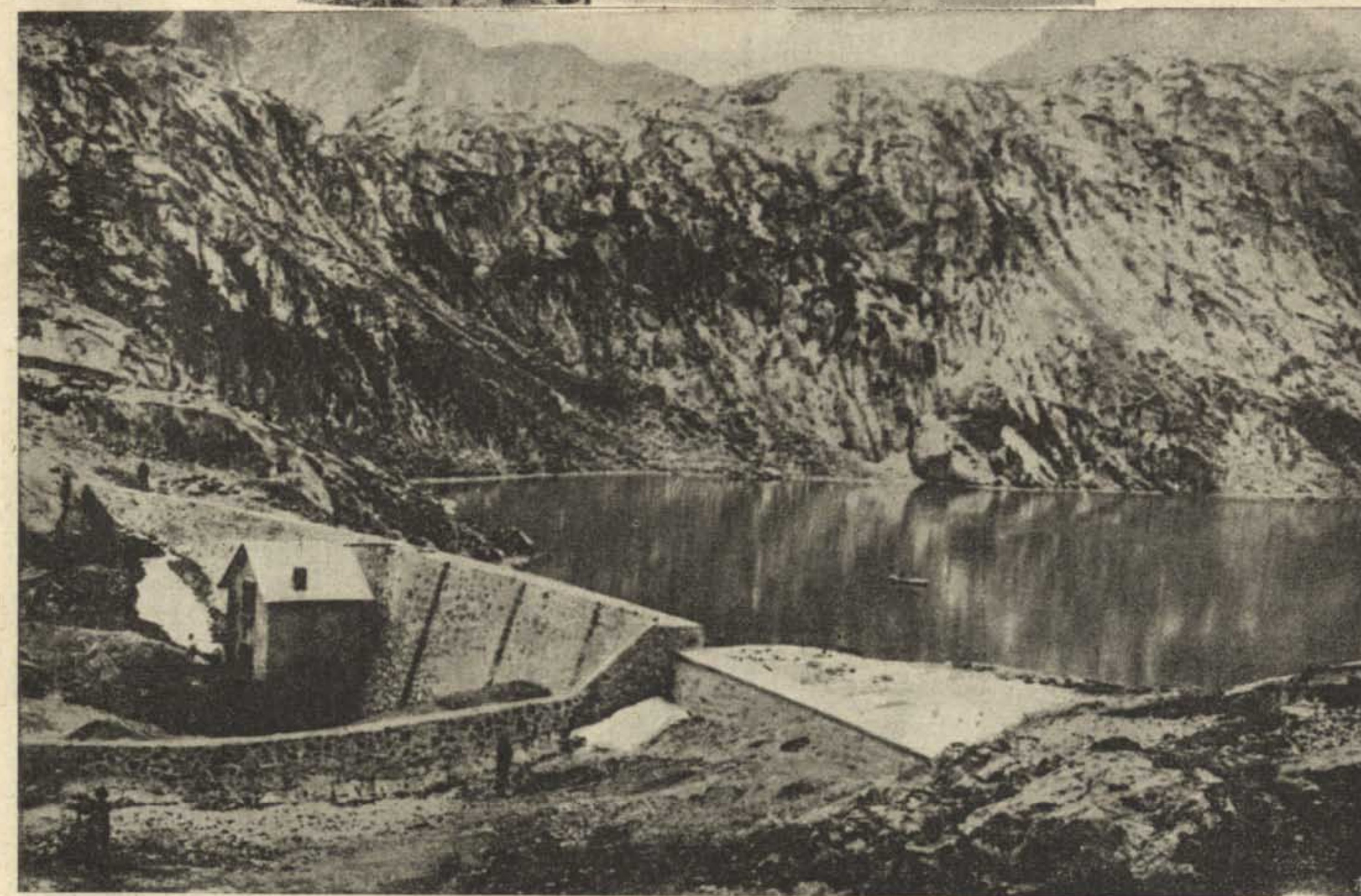
Fig. 2 e 3. — Diga ad arco del Lago Verde [2212 m. s. m.] e diga ad arco del Lago Negro (S. Dalmazzo di Tenda; Ing. Negri, di Savona; impianto idroelettrico Negri). La cresta della diga è a 2270 m. s. m.; ed è perciò la più elevata diga d'Europa.
